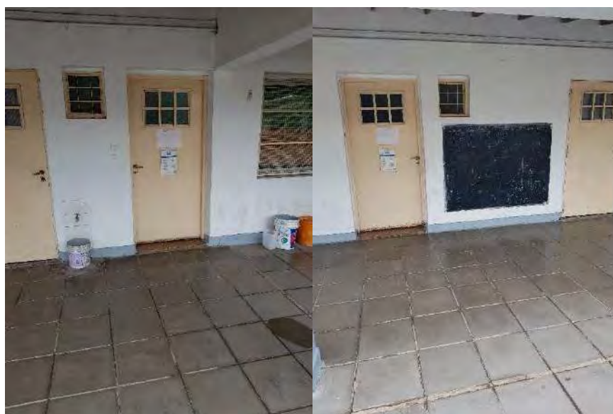
Ubicación de sanitarios habilitados en patio externo
